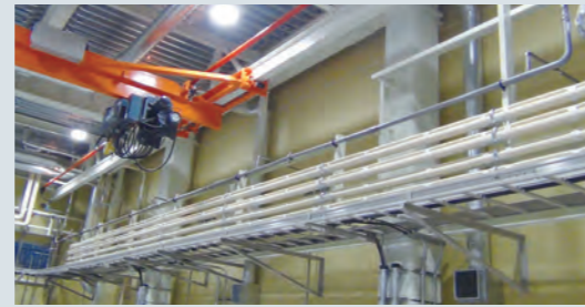
FP35施工実績(三五 豊田技術センターM棟)
