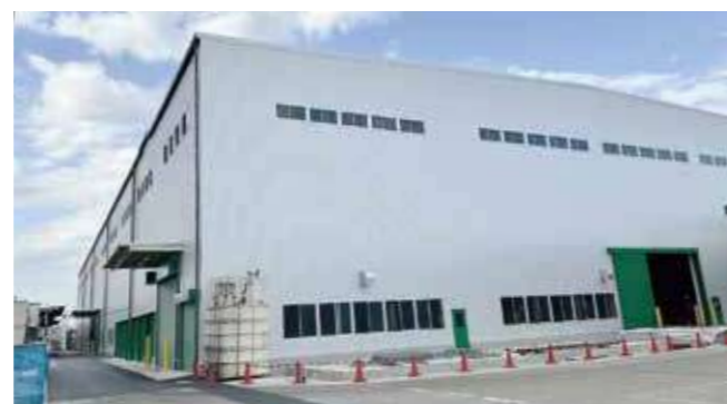
福田北工場プレス棟
